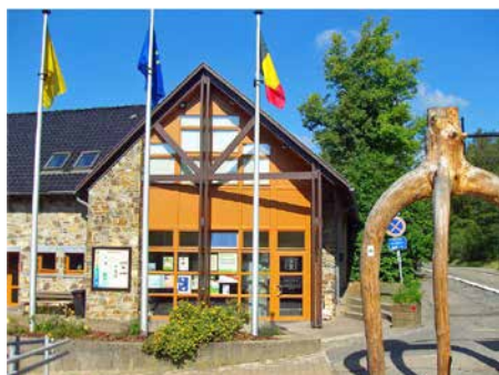
Het natuurcentrum van de Duitstalige gemeenschap, eerste 100% energie-onafhankelijke openbaar gebouw in België.
