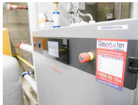
De warmtekrachtkoppelingseenheid in het Huis Ternell.
