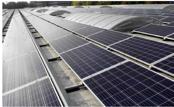
Installatie van 925 fotovoltaïsche panelen op het dak van vzw "Spullenhulp."
